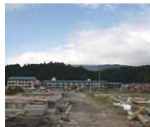
外壁を残し、破壊された県立高田高等学校の校舎(2012年7月撮影)。校舎は2012年秋から解体が始まった。
