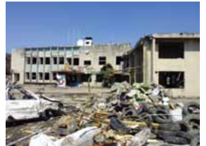
大津波に襲われ、全壊した岩手県大槌町役場。町長を含め、多くの命が失われた現場でもある。
